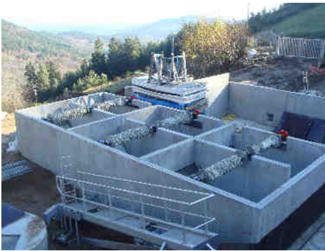
Mise en place des axes des biodisques
