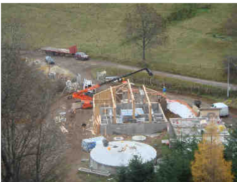
Mise en place de la charpente
