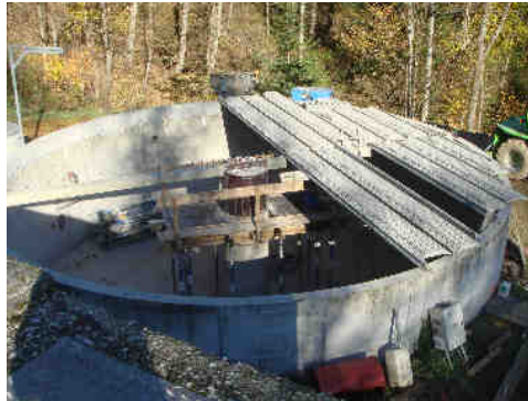
Réhabilitation du clarificateur
