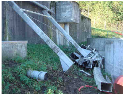
Démantèlement des anciens supports
