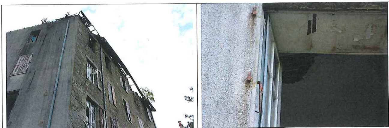
Façades côté maison Grosjean et côté cour ----- Plafonds
