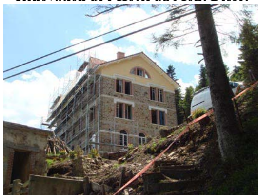
Rénovation de l'Hôtel du Mont Besset
