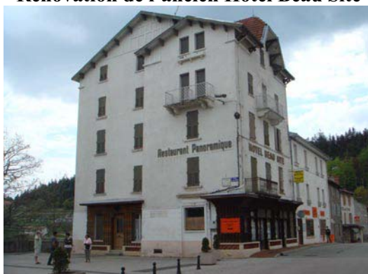
Rénovation de l'ancien Hôtel Beau Site
